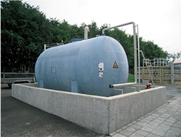
RYS. 5.6 Zbiornik do przechowywania chlorku żelaza. ZDJĘCIE Kemira.
